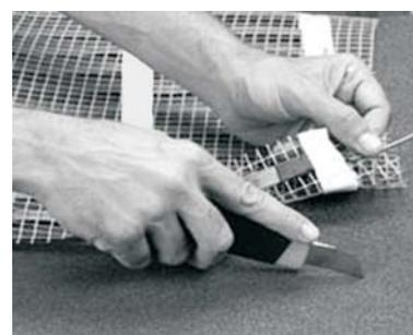
8. Присвойте номер каждой паре холодных проводов, идущих от одного нагревательного мата, и приклейте бирку с номером на конца провода.
